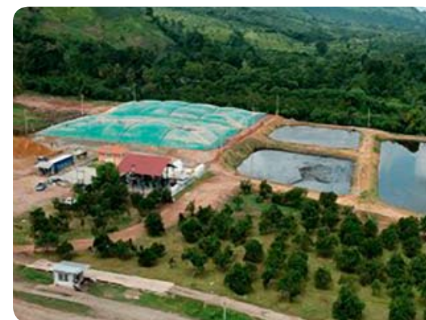
Proyecto de reducción de emisiones (captura de metano): Lagunas anaeróbicas cubiertas, lagunas facultativas y sistemas de infiltración. EECOPALSA, Honduras, 2006.
