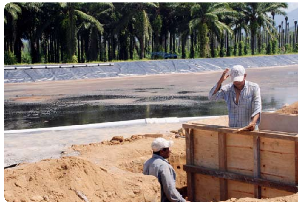
Pilas de tratamiento de aguas residuales en proceso de construcción en Hondupalma, El Negrito, Yoro.
